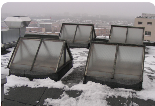
Stan przed wymianą
