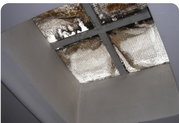
Stan przed wymianą
